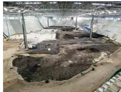
処分場内の様子
